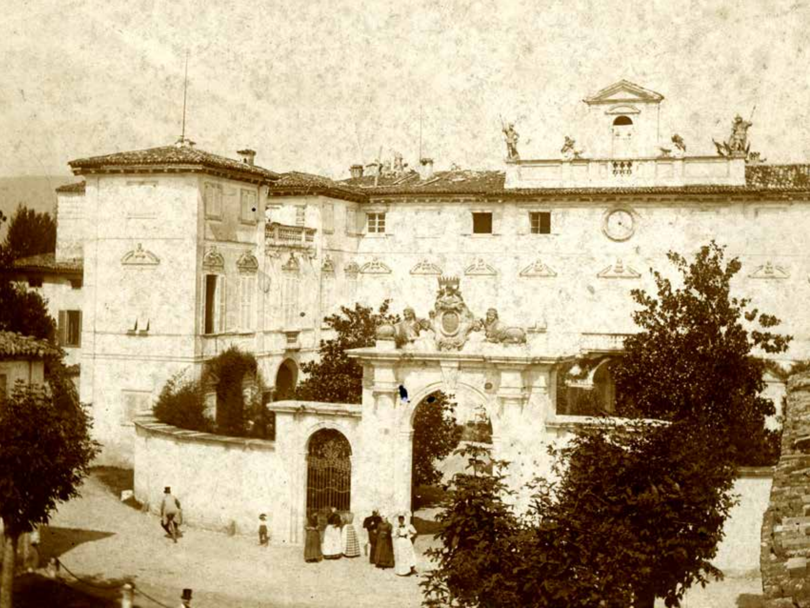
Villa Sottocasa di Pedrengo. 1903, MUST, Collezione Fotografie.
